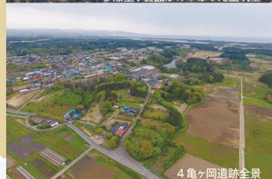
4 亀ヶ岡遺跡全景
