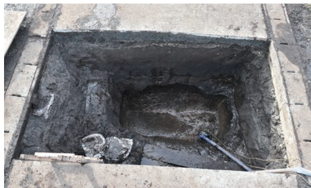
アスファルト舗装の下を調査したよう たくさんの地下水が湧き出てきました。
