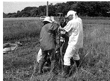
ボーリング・コア採取作業
