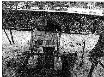
屋外サイン設置作業
