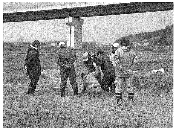
ボーリング・コア採取作業
