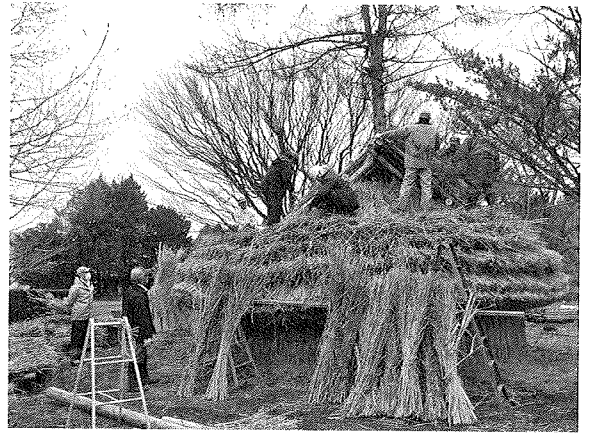
修繕作業の状況
