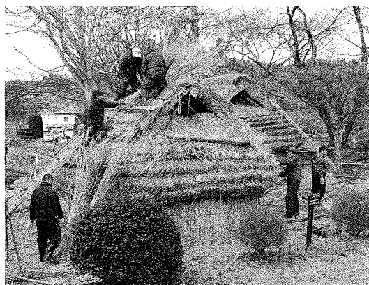
修繕作業の状況
