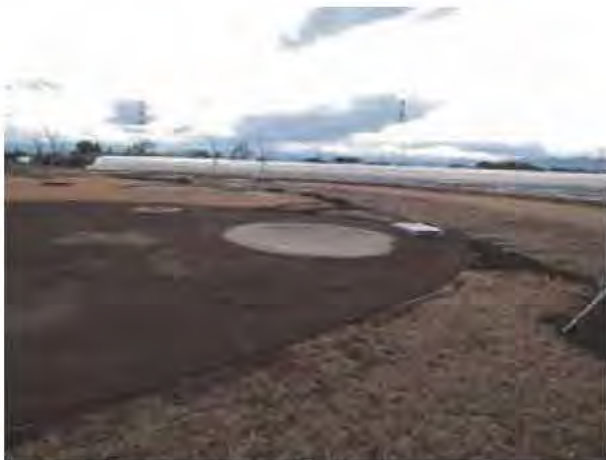
整備事例：西鹿田中島遺跡（群馬県みどり市）
