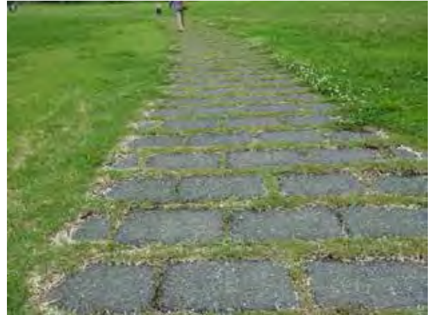
第 41 図 目地を開けてブロックを埋め込む舗装事例 (大湯環状列石)
