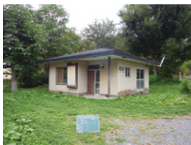
撤去前の平屋建物のようす
