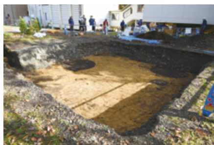
建物を撤去してその下の遺跡を確認
