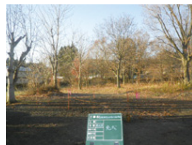
調査と撤去工事が終了
