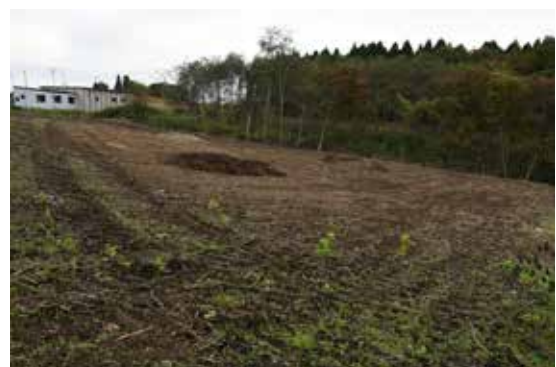
B 地点完掘状況（北東から）
