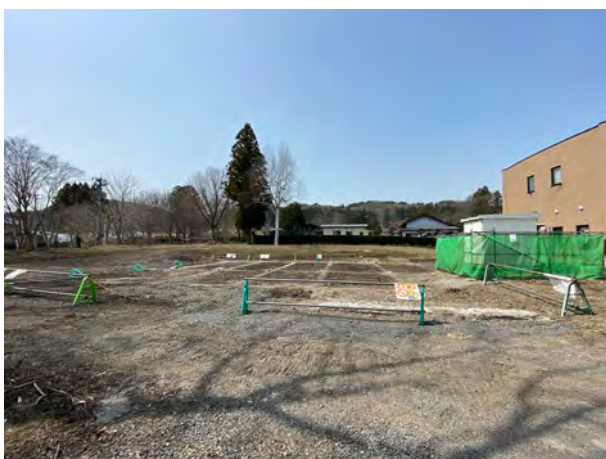
地上部の撤去完了
