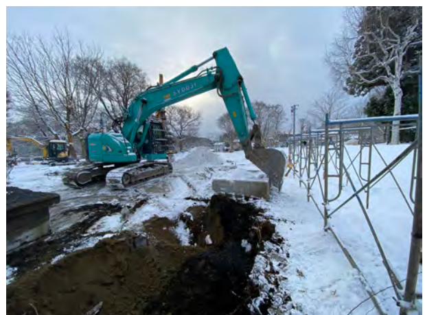
土間コンクリートの撤去
