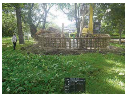
復元竪穴建物の解体
