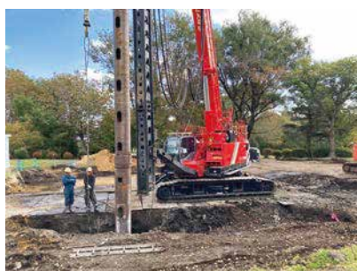
建物基礎の解体工事のようす
