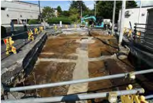
令和6年度調査区全景
