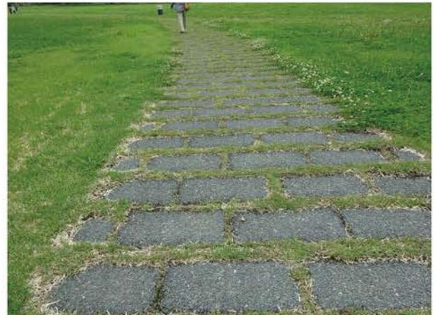
第 25 図 目地を開けてブロックを埋め込む舗装事例
