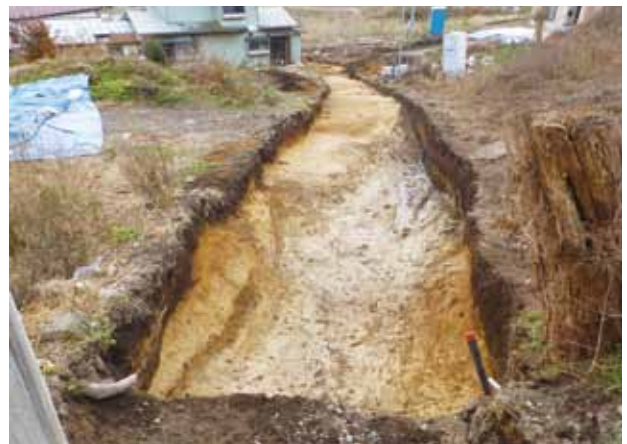
27地点全景（斜面の上から）
